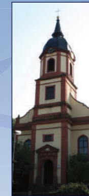
Kath. Kirche St. Bartholomäus Eberbachstr. 8, Haueneberstein
